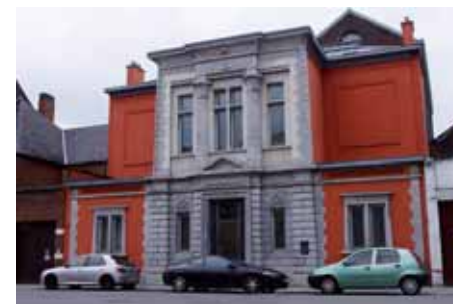
Abb. 24: Fassade des Logengebäudes in der Rue Chisaire in Bergen (Mons) (Foto: Wikimedia Commons).
