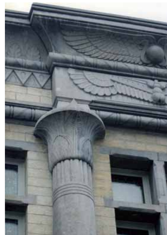
Abb. 25: Detail der Fassade des Logengebäudes in der Rue Chisaire in Bergen (Mons) (Hennaut 2006, S. 142).
