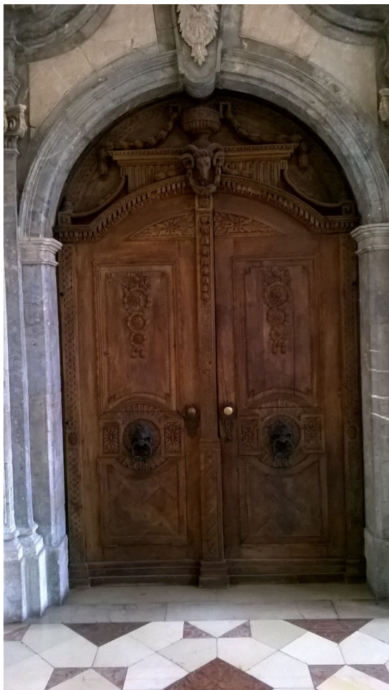
Portal des ehemaligen Tattenbach-Palais aus Buntmarmor, Eichenholz und Bronze. Türflügel von Johann Michael Pössenbacher, München um 1770/72; Portal heute im Zwischengeschoß des BNM (Inventarnr. 31/281; Entwurfzeichnungen dazu ebenfalls BNM; Aufnahme G. Greindl).
