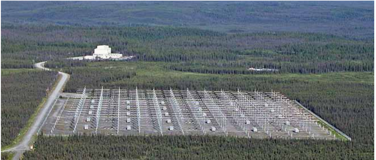
Abb. / image 1: HAARP-Antenne: 180 Kreuzdipole bilden eine horizontale Dipolwand mit ca. 1'000 dB (!) Leistungsverstärkung
