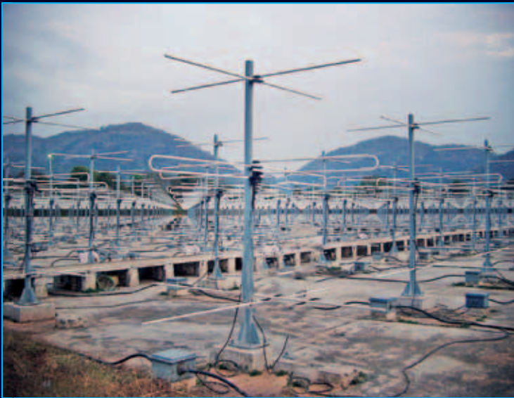
3. National MST Radar Facility, Gadanki, Andra Pradesh, Indien Hochsensitives VHF Phasen-Array-Radar aus 32 Transmittern, das bei 53 MHz mit einer Spitzenleistung von 2,5 MW arbeitet. Hier erforscht man nach eigener Auskunft auch Gravitationswellen.
