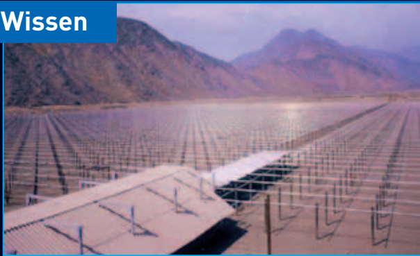
12. Jicamarca Radio Observatory, Jicamarca bei Lima, Peru Perus Scatter-Radar gehört ganz offiziell zum Netzwerk der amerikanischen Ionosphärenradare, für das es den „äquatorialen Anker“ bildet. Jicamarca operiert bei 49,92 MHz bei einer Transmitterleistung von etwa 1,5 MW.
