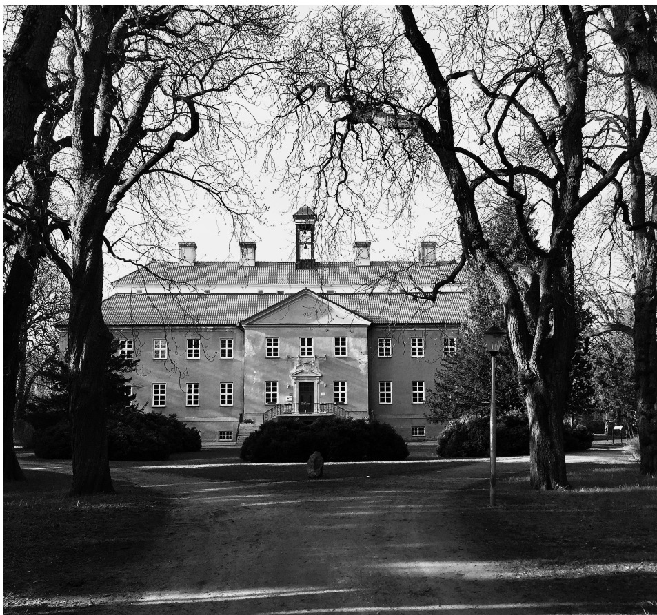
Schloss Griebenow, Foto: Michael North
